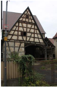
Abbildung 21 Schmale Gasse 9 (Fachwerkscheune) (Quelle: WHS, 2018)
