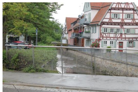
Abbildung 61: Schippe fehlender Fuß- und Radweg (Quelle: WHS, 2018)
