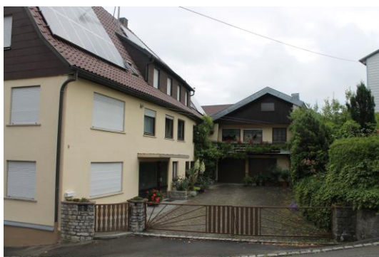
Abbildung 7: Photovoltaikanlage in der Grabengasse 4 (Quelle: WHS, 2018)
