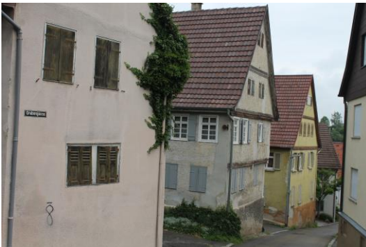
Abbildung 15: Grabengasse 3 (mitte) (Quelle: WHS, 2018)
